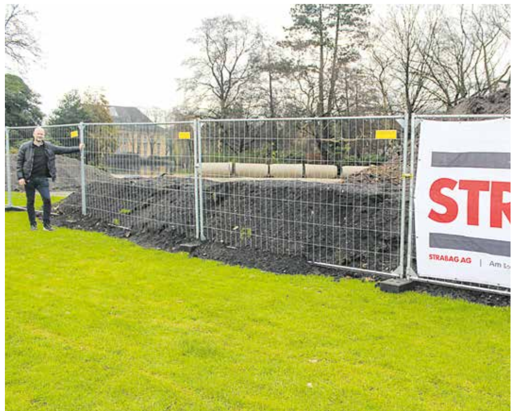
Mike Böge vom iro-Rohrleitungsforum besichtigte die Baustelle zur Kanalsanierung und Neuverlegung vor Weihnachten. Foto: Inge Meyer
