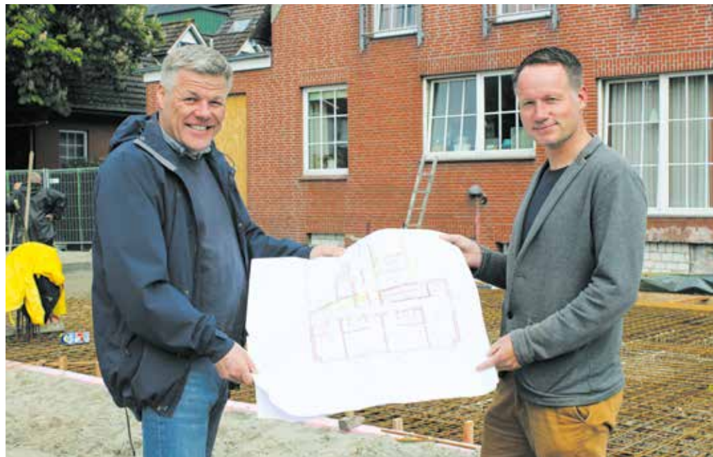
Von links: Matthias Wahrheit und Hotelier Eicke Germis konnten die Bodenplatte für den zweigeschossigen Neubau bei guter Witterung fertigstellen. Foto: Inge Meyer
